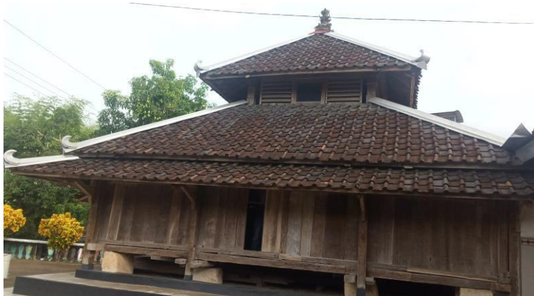
Gambar 5. Miniatur Masjid Demak. Masjid ini dinamakan Masjid Tiban . Diduga dibangun pada abad XVI atau menurut catatan pada 1477 oleh para Walisongo, mendahului pembangunan Masjid Demak, yakni saat perjalanan pencarian bahan kayu ke Aas Donoloyo, Wonogiri bagian timur. Terletak di Dukuh Wonokerso, Desa Sendangrejo, Kecamatan Baturtno, Kabupaten Wonogiri (Dokumen pribadi).
